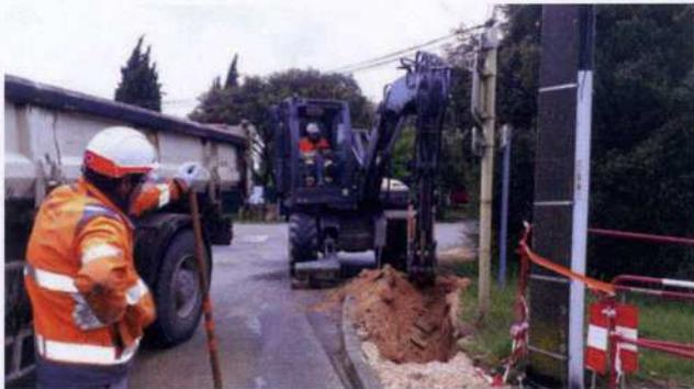
Les travaux d'enfouissement des réseaux de téléphonie et d'électricité touchent à leur fin. Après des mois de chantiers perturbés par la crise sanitaire, il ne reste plus qu'à attendre le raccordement des réseaux de téléphonie pour procéder au démontage des poteaux. Ce chantier, d'un montant global de 250 000 €, mené en partenariat avec le Syndicat Mixte d'Electricité du Gard représente au total un investissement de 90 000 € pour la commune dont 20 000 € de subventions.
